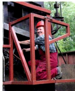
Betriebschlosser Martin Rüniger auf seiner Reparaturplattform
